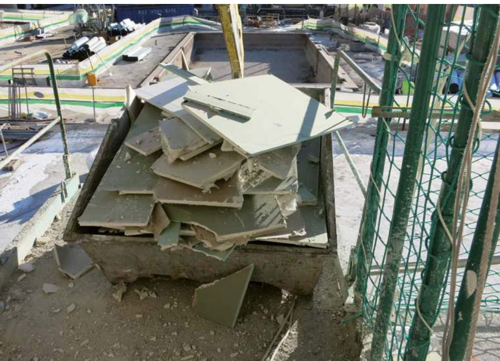
Residuo de Placa de Yeso Laminado procedente de una obra de construcción de viviendas.
