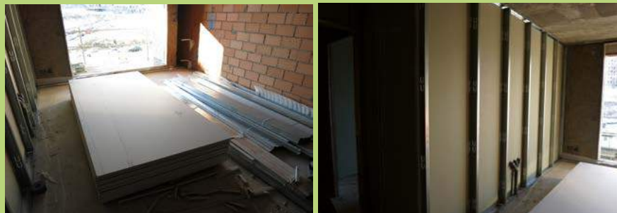
Sistema constructivo de Placa de Yeso Laminado utilizado en particiones.
